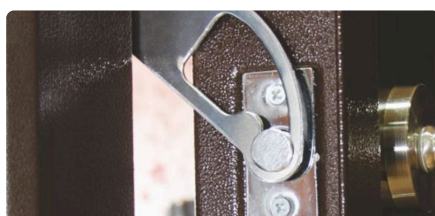
Points anti-dégondage Crochets côté charnières
